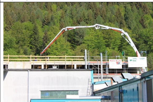
05.05.2011 (Dach wird betoniert)
